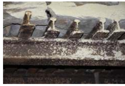
Blick auf den Ausbau an der Firste (Decke)
