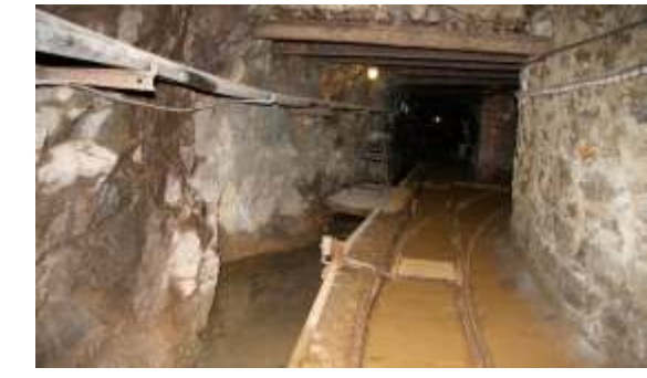
Bild 2887: Die Gleise für den Transport der Bergleute oder des Erzes verschwinden im Dunklen der Strecke
