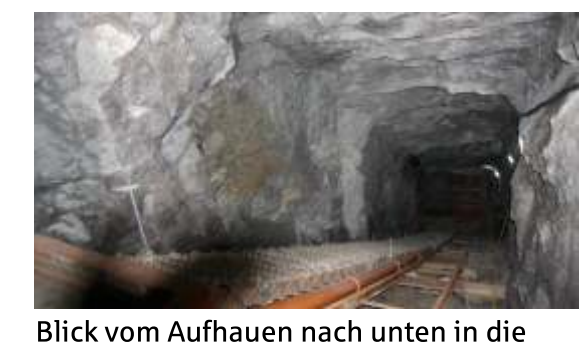
Blick vom Aufhauen nach unten in die Fußstrecke
