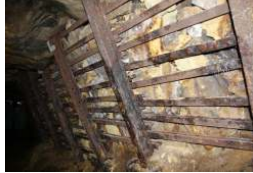
Eiserner Ausbau – notwendiger Schutz für stabile Strecken
